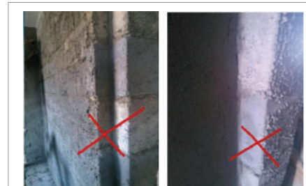
甩浆时,应注意门垛侧面,墙体阴角等地方止扯皮
