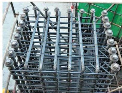
该技术相比传统的钢筋机械锚固技术,在混凝土结构中使用钢筋锚固板,可减少钢筋锚固长度,节约锚固钢筋;锚固板与钢筋端部通过螺纹连接,安装快捷,质量及性能易于保证;锚固板具有锚固刚度大、锚固性能好、方便施工;可大大简化钢筋工程的现场施工,避免了钢筋密集拥挤、绑扎困难的问题,可改善节点受力性能和提高混凝土浇筑质量。
